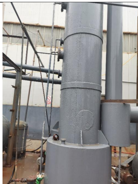
4. 硫酸铁车间废气处理设施
